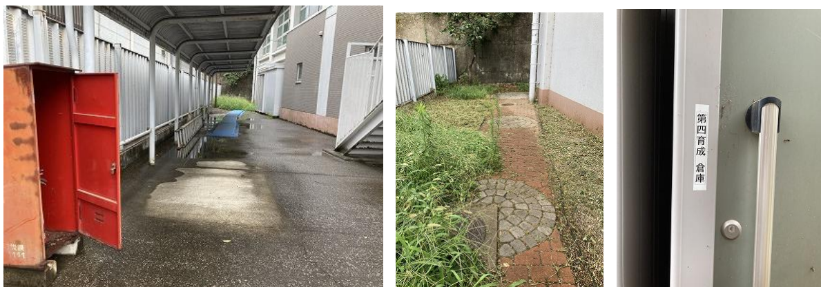
出口近くには消火器2本。体育館を出て右にいくと雨水槽2個。第四育成の倉庫。
